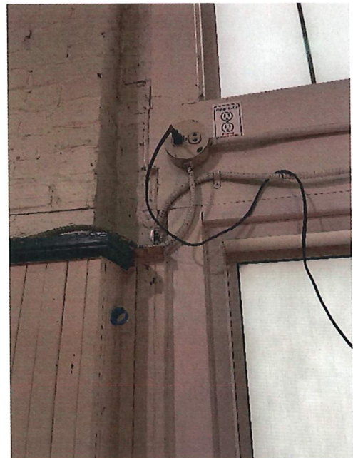
Non grounded outlet
